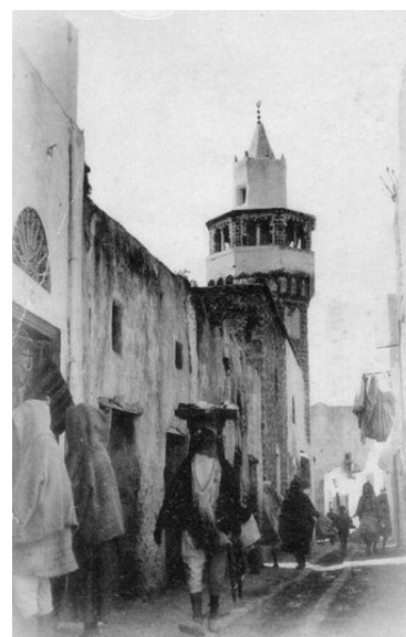
Fig. 16 - Vue ancienne de la Grande Mosquée de Bizerte et de son minaret de tradition ottomane. ►
